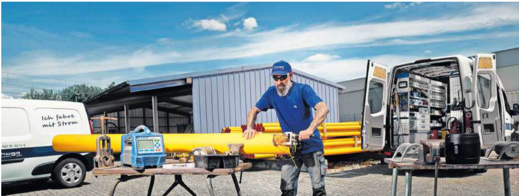
Vorbereitende Arbeiten an einem PE-Rohr zur künftigen Versorgung mit Wasserstoff.
